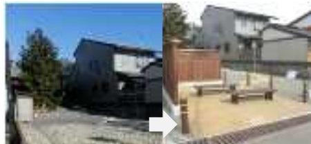
景観に配慮した空地の広場化（高山市）
