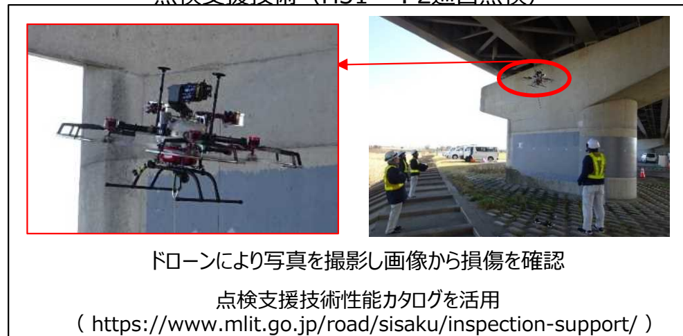
点検支援技術 (H31~ : 2巡目点検)
