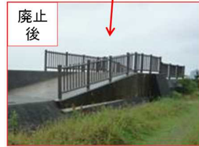
スロープを設置し陸閘を廃止
