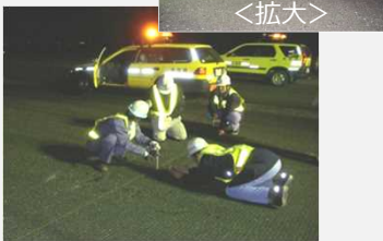
<わだち掘れ計測>
