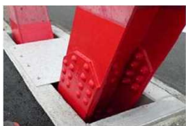
▲ 破断箇所の修復
