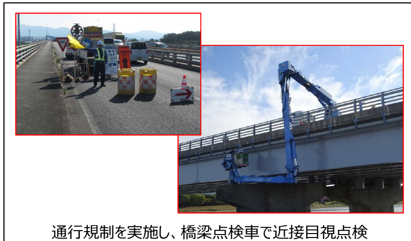
従来点検 (H26~H30 : 1巡目点検)
