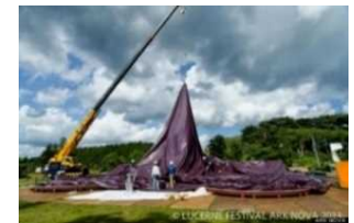
設置中の様子 (出典) 東京ミッドタウンマネジメント株式会社HP
