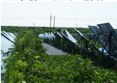
放置されたパネルの現況
