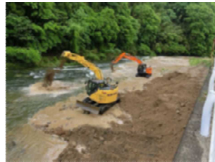
フラッシュ放流・土砂還元 の状況
