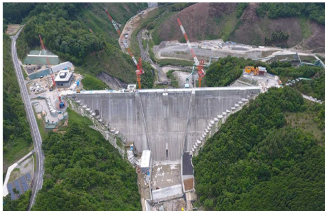
ダム下流側より(ダム右岸側より)(R3.5)
