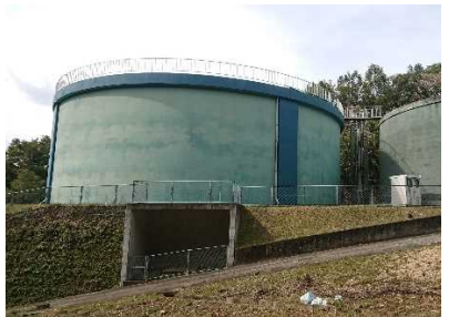
恩ヶ芝配水池
