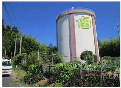
大野配水場 出典:奈良県より提供
