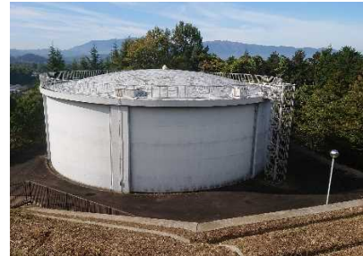
高家配水池 出典:奈良県より提供
