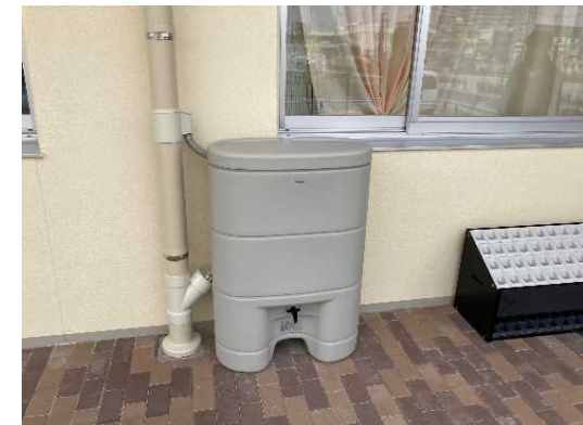
雨水貯留タンクの設置状況
