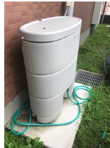
雨水貯留タンクの設置状況
