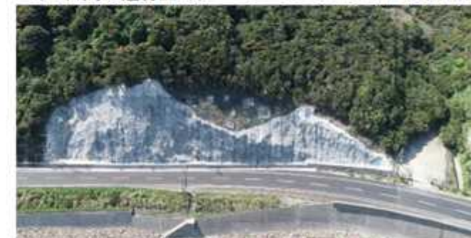
法面吹付工、落石防止網工
