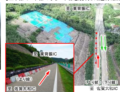
【上り線で2車線のうち1車線を規制した通行確保】
