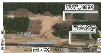
広島呉道路・国道31号の被害状況
