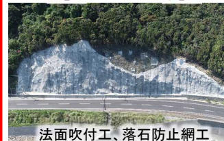
法面吹付工、落石防止網工
