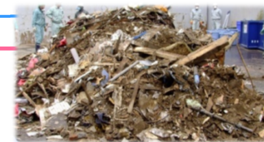
解体現場における混合廃棄物
