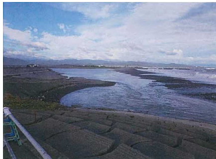
作業ヤード・工事用道路盛土の流出
