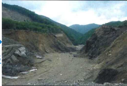
仮排水路延伸工の被災
