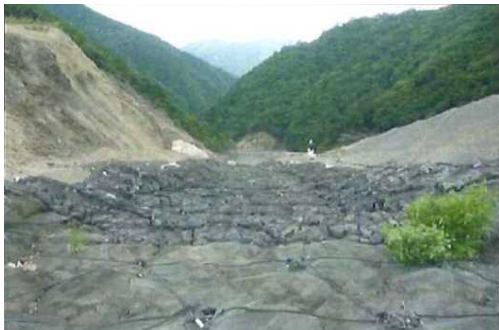
仮排水路延伸工の被災
