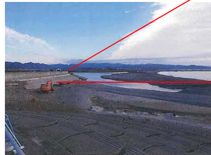
作業ヤード・工事用道路盛土の流出
