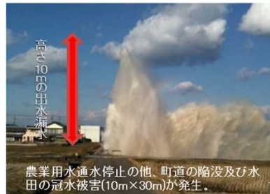
漏水による周辺陥没状況
