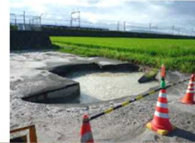
漏水による周辺陥没状況
