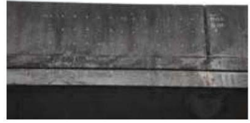
壁高欄(健全コンクリート)
