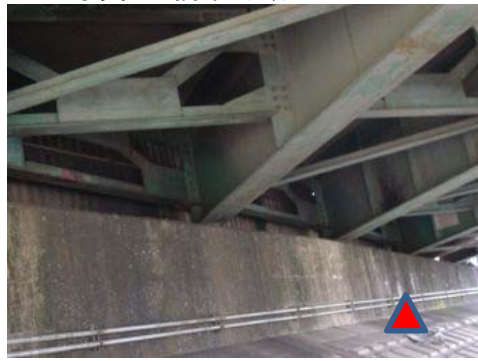
写真-3 測定対象の支承
