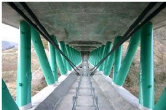
写真-4 外ケーブル
