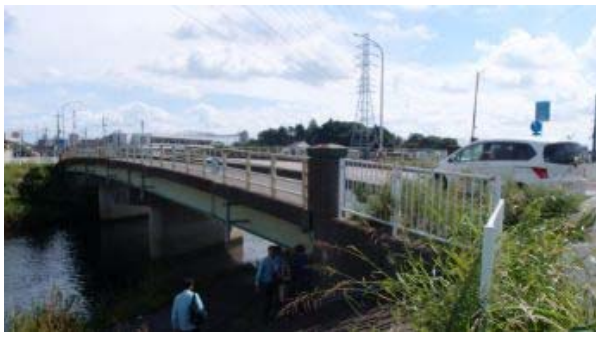
写真-1 橋梁外観
