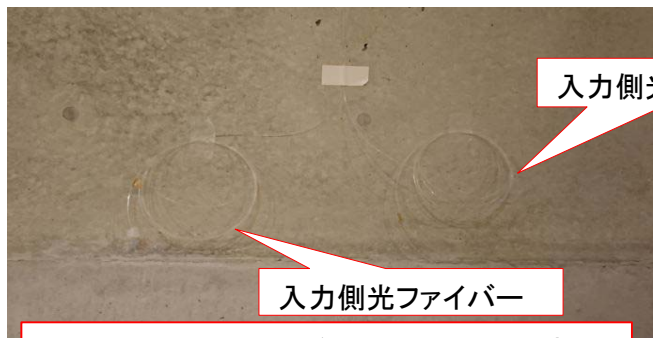
写真-3 光ファイバー設置状況(側壁)
