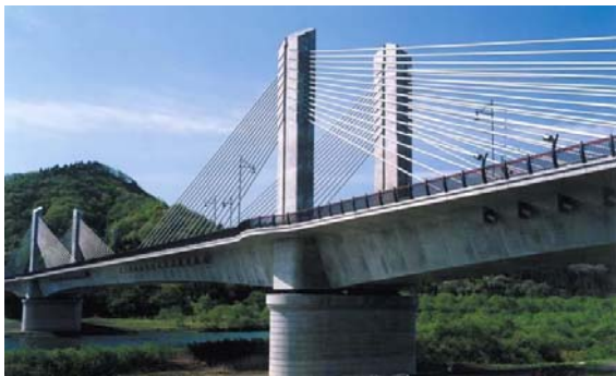
写真-3 エクストラドーズド橋
