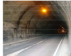
トンネルのひび割れ幅 モニタリング
