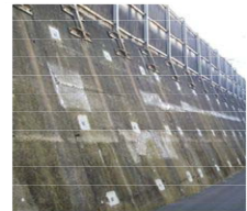
ロックボルト付近のひずみ モニタリング
