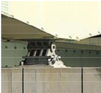
橋梁（支承）の変位 モニタリング
