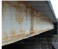
橋梁（桁）の応力 モニタリング
