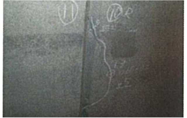
付写真-1.1.1 横断目地の天端付近に発生した半月状のひびわれの例
