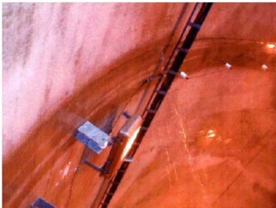
付写真-1.4.3 漏水（噴出）している例
