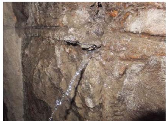
付写真-1.4.3 漏水（噴出）している例
