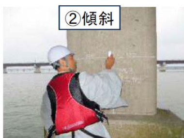
柱の傾斜測定
