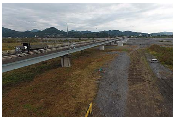
施工前の全景
