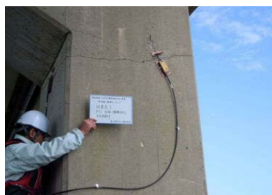
橋軸方向の地震、不同沈下の影響を計測
