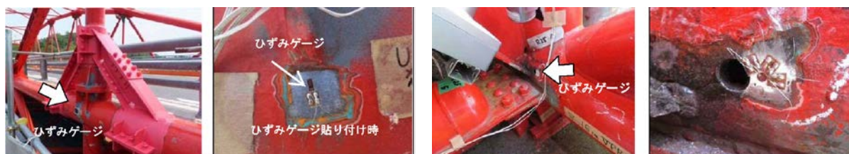
格点補強部のひずみ計測
