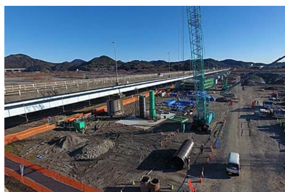
施工中の全景
