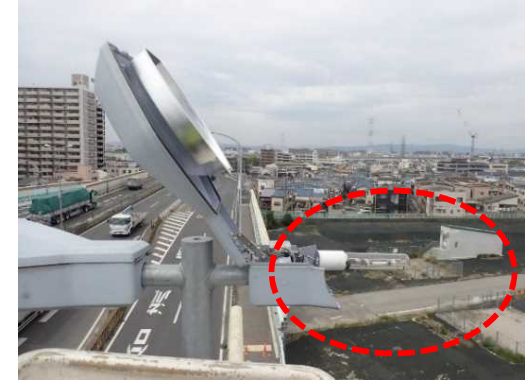
破損し落下した照明灯具(国道25号)
