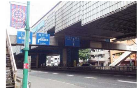
横断歩道橋 (全景)
