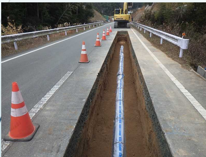
管路耐震化工事
