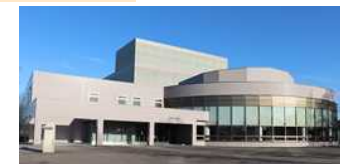
防災体制構築に必要な防災設備の改修総合文化会館防災対策(中標津町)
