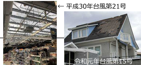
台風による屋根ふき材の被害例
