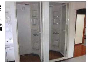
シェアハウスの改修
