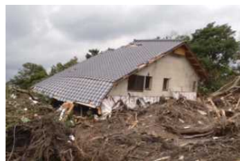
土石流による被災(伊豆大島)
