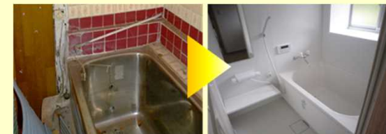
空き家(内装)改修前後
