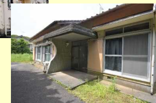
短期滞在住宅外観(五島市提供)
