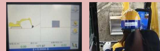
ICT施工(3次元データを重機に読み込み確認しながら施工)
