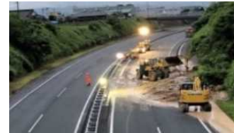
被害のない2車線を活用し、交通機能を確保
