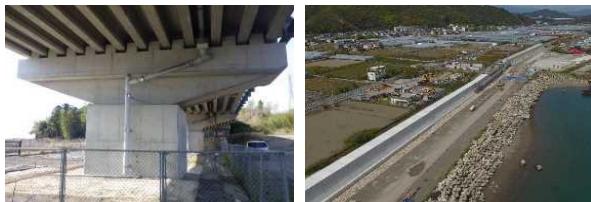
緊急輸送道路上の橋梁の耐震化 河川堤防・海岸堤防等の整備
