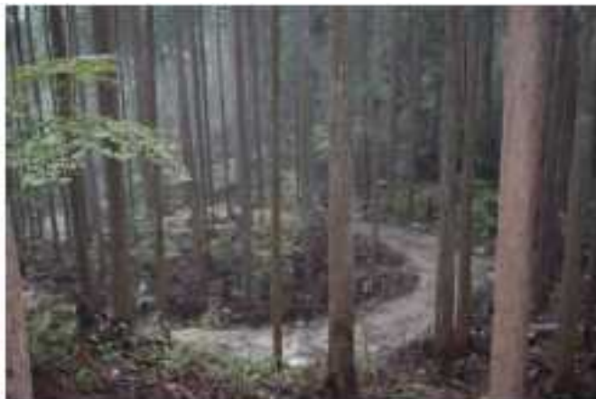
【林道・森林作業道の整備】
