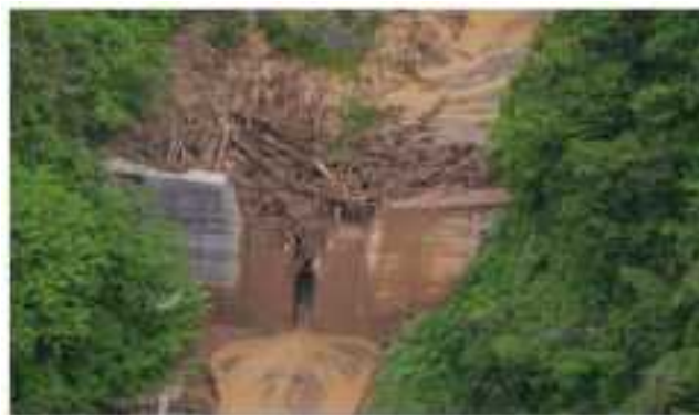
【砂防施設の土石流・流木捕捉事例】
