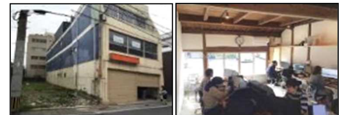
空きビルを活用した、サテライトオフィスとしての利活用
