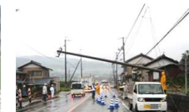
沿道の電柱の倒壊による道路閉塞
