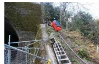
資材運搬のための索道
