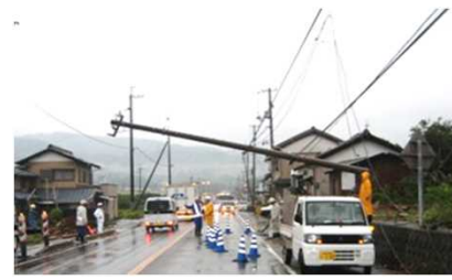
沿道の電柱が倒壊し、緊急輸送道路の閉塞が発生した例
