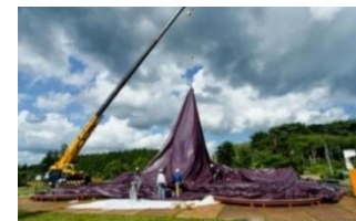
設置中の様子
