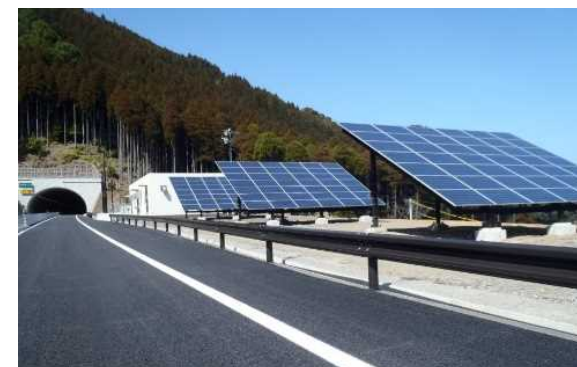
道路を活用した太陽光発電
