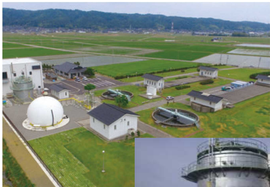
上：施設全景 下：メタン発酵槽
