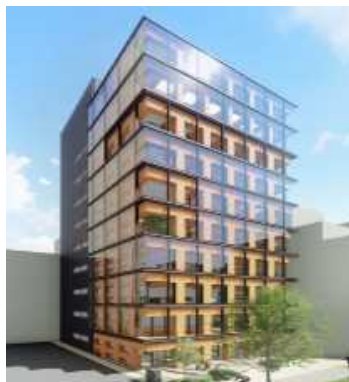
純木造による 11階建ての研修所
