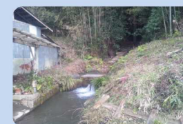
▲ 発電所設置前の状況
