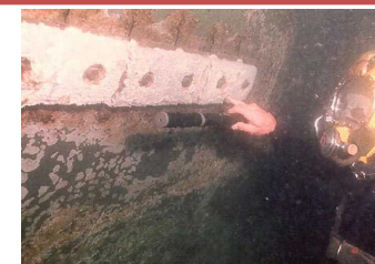
構造体の腐食防止措置の検査
