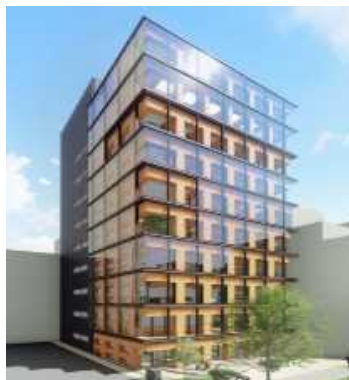
純木造による 11階建ての研修所
