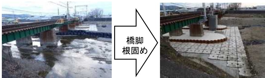
河川・砂防・鉄道・道路分野が連携した橋脚等の防災・減災対策
