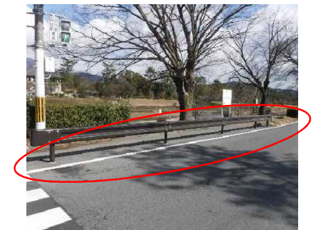
【防護柵の設置】
