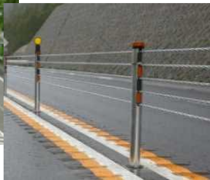
<ワイヤロープの設置事例>
