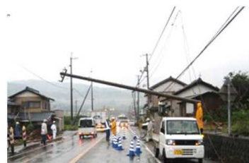
沿道の電柱が倒壊し、緊急輸送道路の閉塞が発生した例 (平成24年8月)
