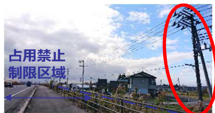
占用禁止制限区域の沿道に設置された電柱の例
