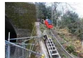
資材運搬のための索道
