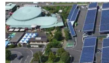
太陽光発電施設の設置
