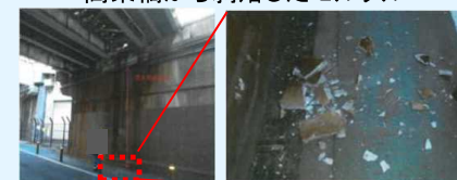
高架橋から剥落したモルタル
