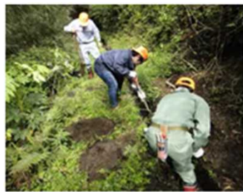
水路の清掃（日南市）
