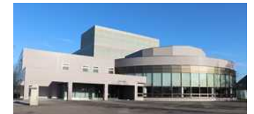
防災体制構築に必要な防災設備の改修総合文化会館防災対策(中標津町)
