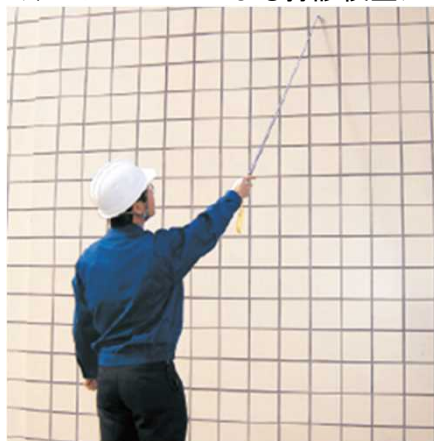
<テストハンマーによる打診検査>
