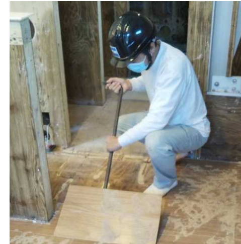
応急仮設住宅の建設 / 床上浸水した家屋の補修
