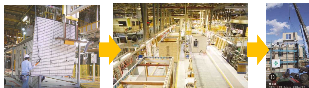
現場施工は棟上げが一日で完了
