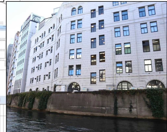
川から見た日証館
