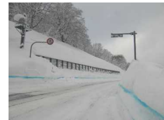
青い塗料(ブルーライン)の塗布 (山形河川国道事務所管内)
