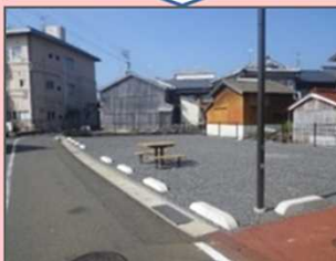
居住環境の整備改善のため、 空き家を除却しポケットパークを整備
