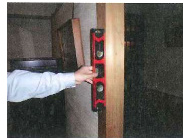
水平器による柱の傾きの計測
