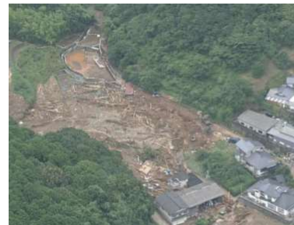
▲ 令和2年7月豪雨による土砂災害の被害(熊本県)
