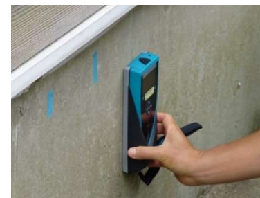
基礎配筋の調査
