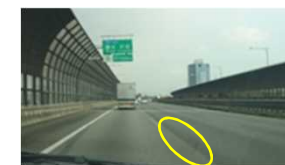
▲白線の消えかかり
