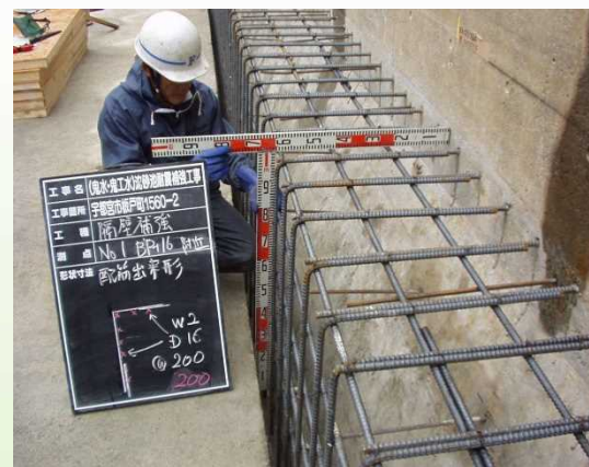
沈砂池耐震化工事
