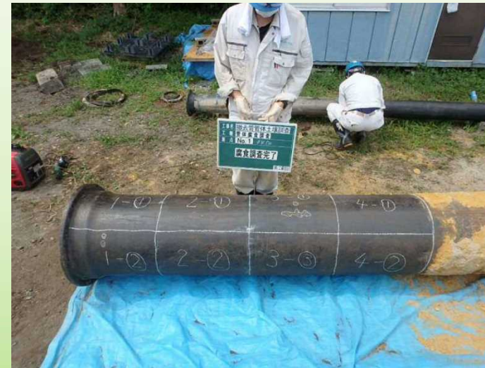
配水管路の劣化診断調査
