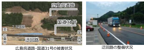
広島県道路・国道31号の被害状況
