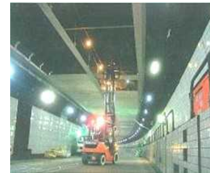
天井板の撤去・設置
