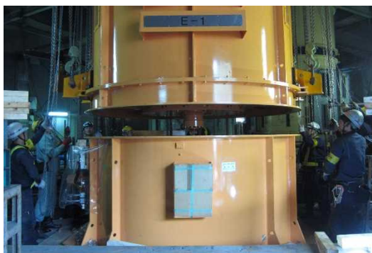
換気設備の更新
