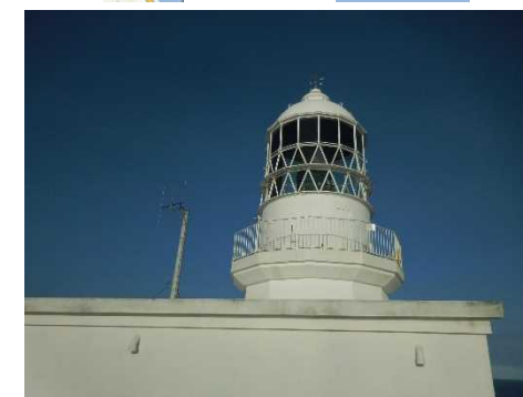
大島の鞍碕灯台
