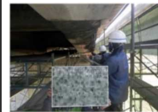
修繕の様子(断面修復)
