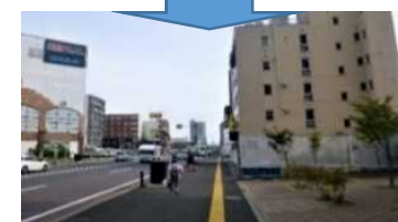
整備後(撮影 令和元年度)
