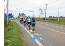
路面への通行位置明示
