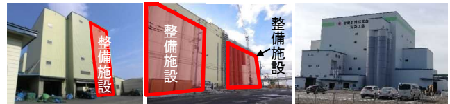
需要の増加と出荷作業の効率化に対応した製品用サイロ増設 西港区に進出する飼料工場への原料供給に対応したサイロ増設 畜産用を含む多様な配合飼料を供給する飼料工場建設
