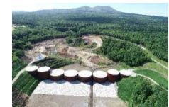
樽前山覚生川2号砂防堰堤(苫小牧市)
