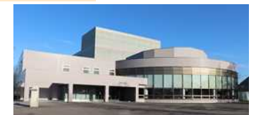
防災体制構築に必要な防災施設の整備 ネットワークの整備(一般国道44号根室道路) 総合文化会館防災対策(中標津町)
