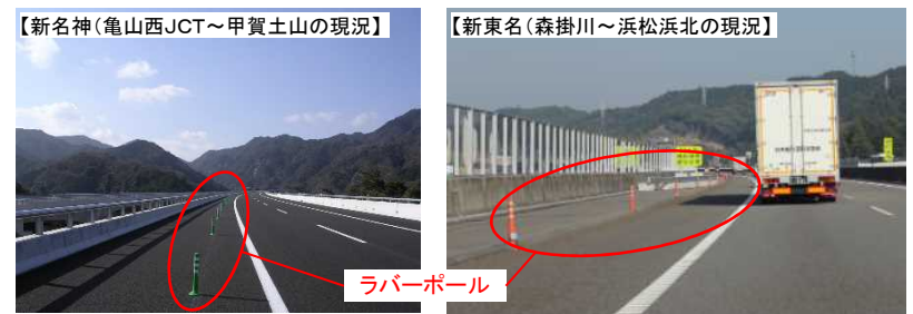
現況写真(構造物6車線対応区間)
