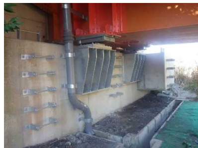
支承補強(水平力分担構造)
