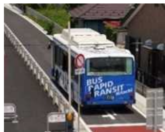
ひたちBRTの事例(茨城県日立市)
