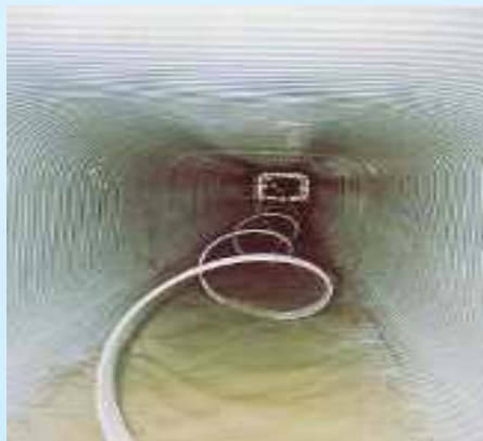
更生工法による長寿命化(下水道)
