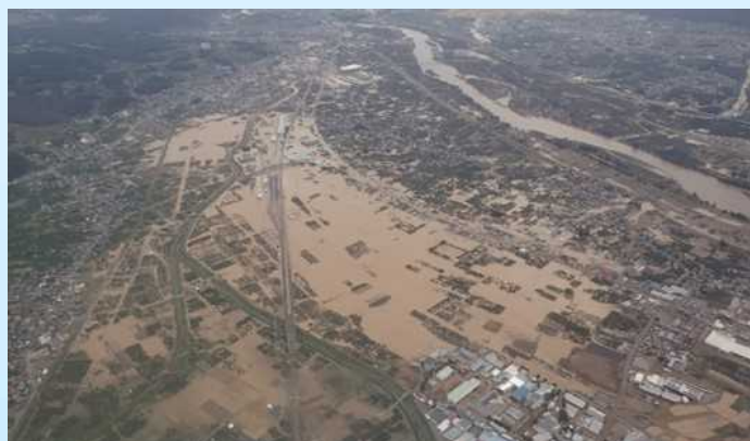
令和元年東日本台風による被害(千曲川)
