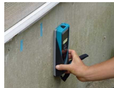
基礎配筋の調査
