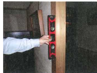
水平器による柱の傾きの計測
