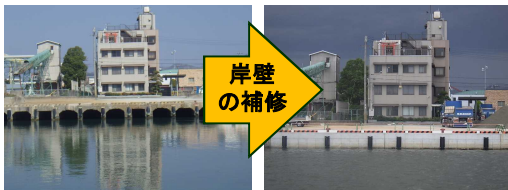
老朽化した岸壁の補修
