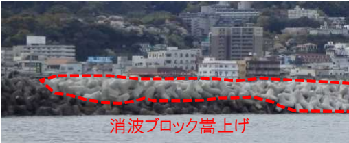
防波堤の沈下した消波ブロックの嵩上げ
