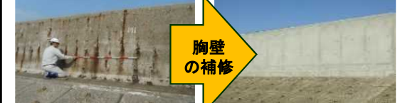
コンクリート劣化・鉄筋露出
