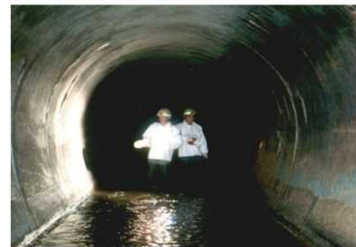
・潜行目視による点検・調査
