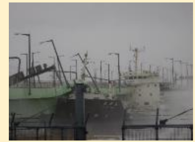
関空連絡橋に衝突したタンカー
