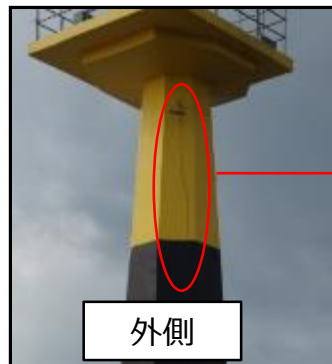
〔灯塔亀裂（貫通状態）〕
