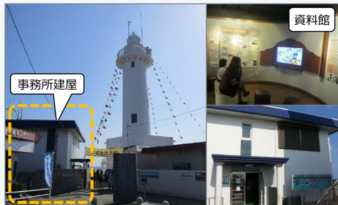
大王埼灯台（三重県志摩市）
