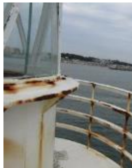
〔灯台（外部、上部、基礎部）の発錆状況〕
