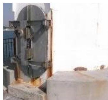
〔灯台（外部、上部、基礎部）の発錆状況〕
