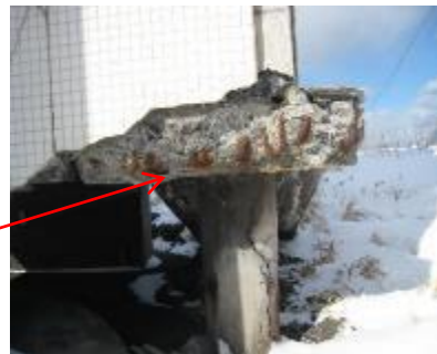
〔灯台タイル及びコンクリートの劣化状況〕
